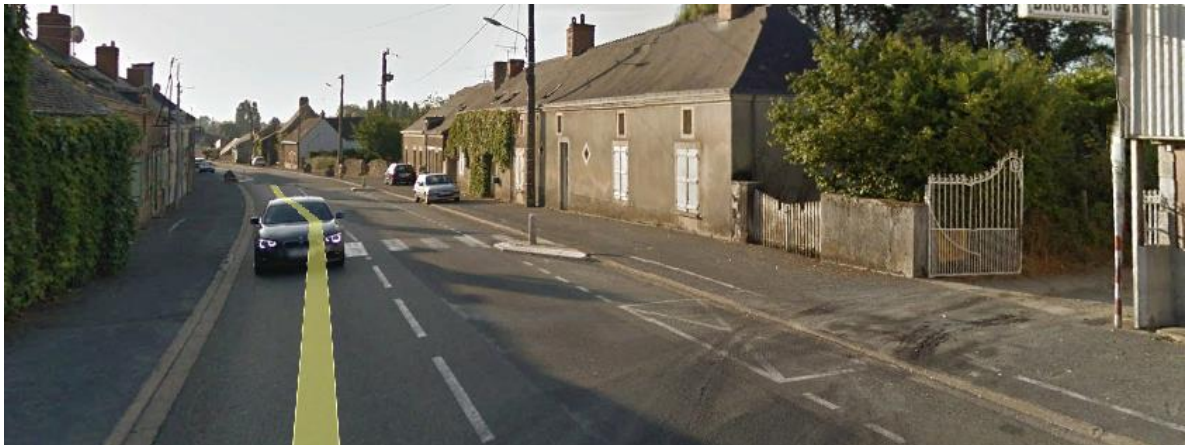
Trottoirs bilatéraux existants rue Principale
