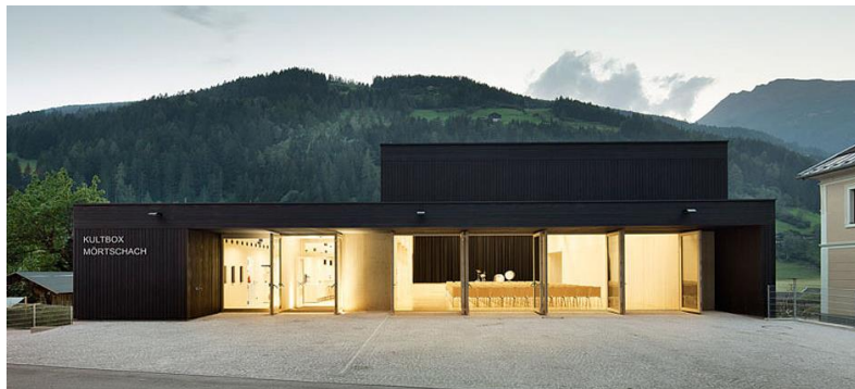
Exemple de bâti écologique et bioclimatique avec de grandes ouvertures (à privilégier sur les façades sud et est) – Source : holtzauaustria.at
